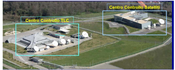
Figura 28- Centro di Controllo SICRAL di Vigna di Valle
